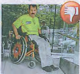
In der Wirtschaftskammer ist die Eingangsrampe zu steil. Danach keine Orientierungshilfe.
